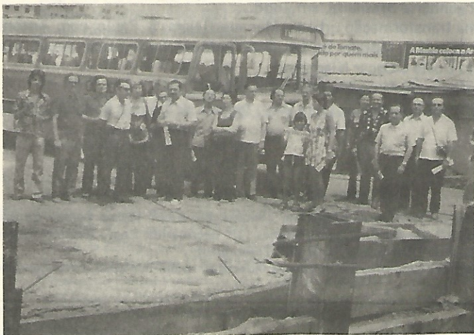
Caravana de técnicos e convidados da A 3 P, no Canteiro de Obras do Metrô Paulista.
