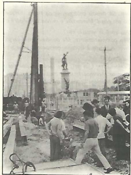
No local da cravação das estacas metálicas para contenção, na Cinelândia, vendo-se ao fundo a estátua do Mal. Deodoro.
